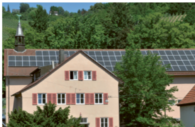
Es muss nicht immer eine Kirche sein: 2012 entstand diese PV-Anlage auf dem Gemeindehausdach in Esslingen-Mettlingen.
