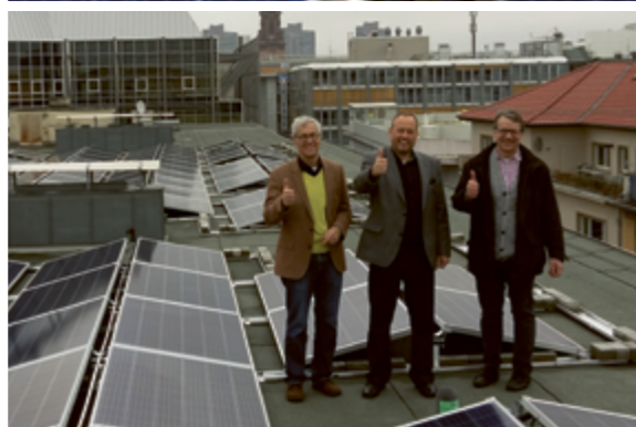
Oben: Kinder auf dem Kita-Dach? - Zur Einweihung der PV auf der Mannheimer Kita am Brunnengarten gab's eine Ausnahme. Unten: Noch ziemlich jung ist die Solaranlage auf dem Haus der Evangelischen Kirche, ebenfalls in Mannheim.
